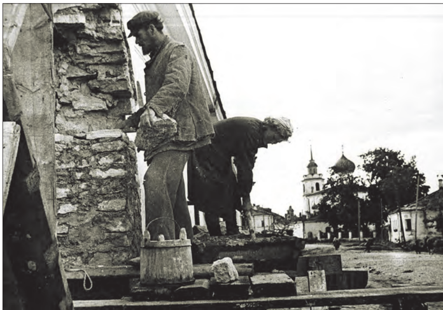
Рабочие Н.Золотцев и А.Дмитриева ремонтируют дом. Сентябрь 1944 г. ГАПО
