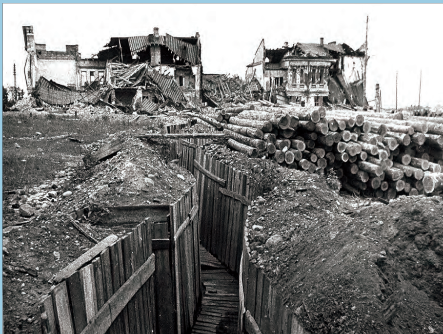
Немецкие траншеи. Июль 1944 г. ГАПО
