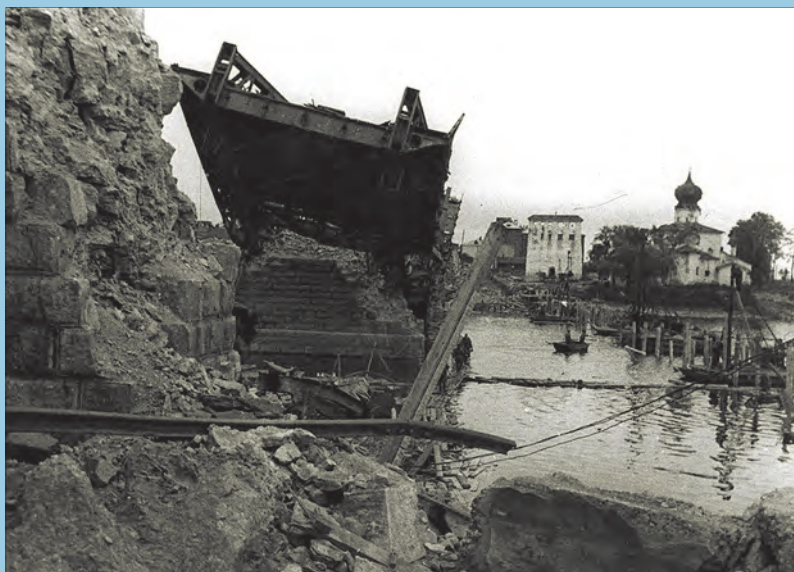
Ольгинский мост, разрушенный немцами при отступлении (фото сверху)
