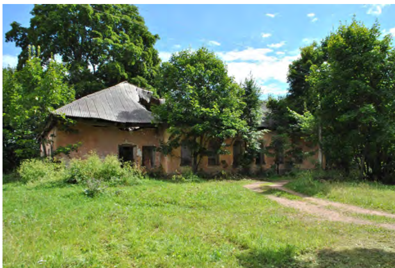
Заброшенное здание Знаменской школы, современное состояние
