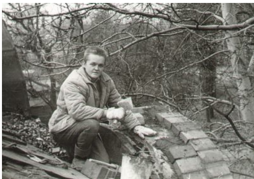
Каменщик-реставратор А. Н. Ефимов на реставрации церкви Александра Невского Омского полка. 1993 г.
