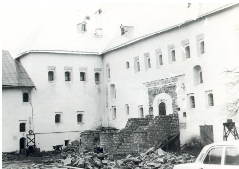
Воссоздание каменной части крыльца палат Поганкина. 1995 г.
