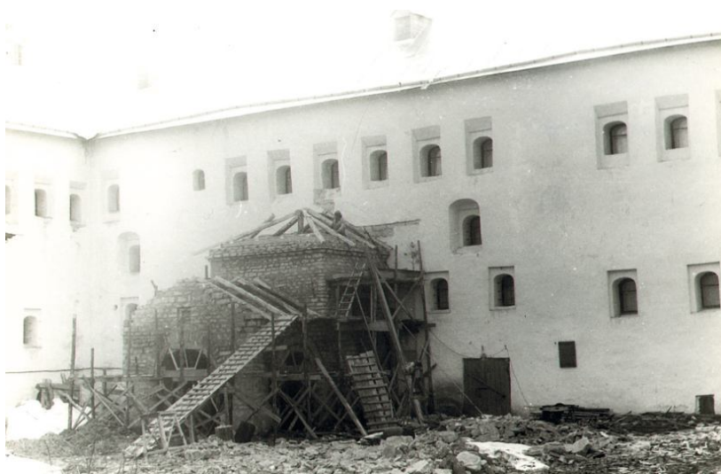
Воссоздание каменной части крыльца палат Поганкина. 1995 г.
