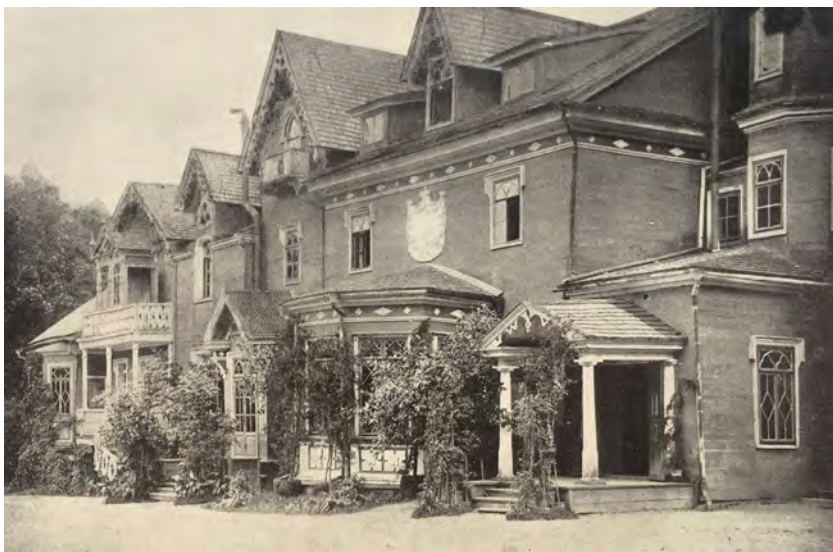
Поместье в Глубоком с родовым гербом на фасаде
