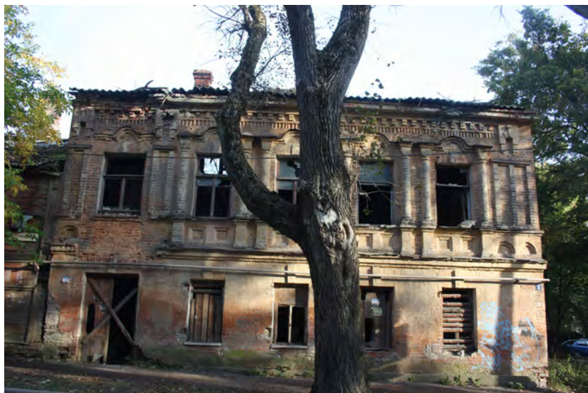
Некогда жилой дом на ул. О. Кошевого
