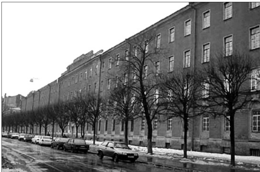
Санкт-Петербург, здание бывшего Дворянского полка
