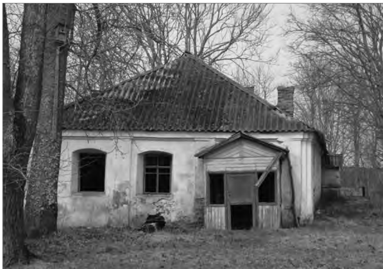
Рис. 2. Келейное здание до ремонта, 2010 г. Фото Е. Юриновой
