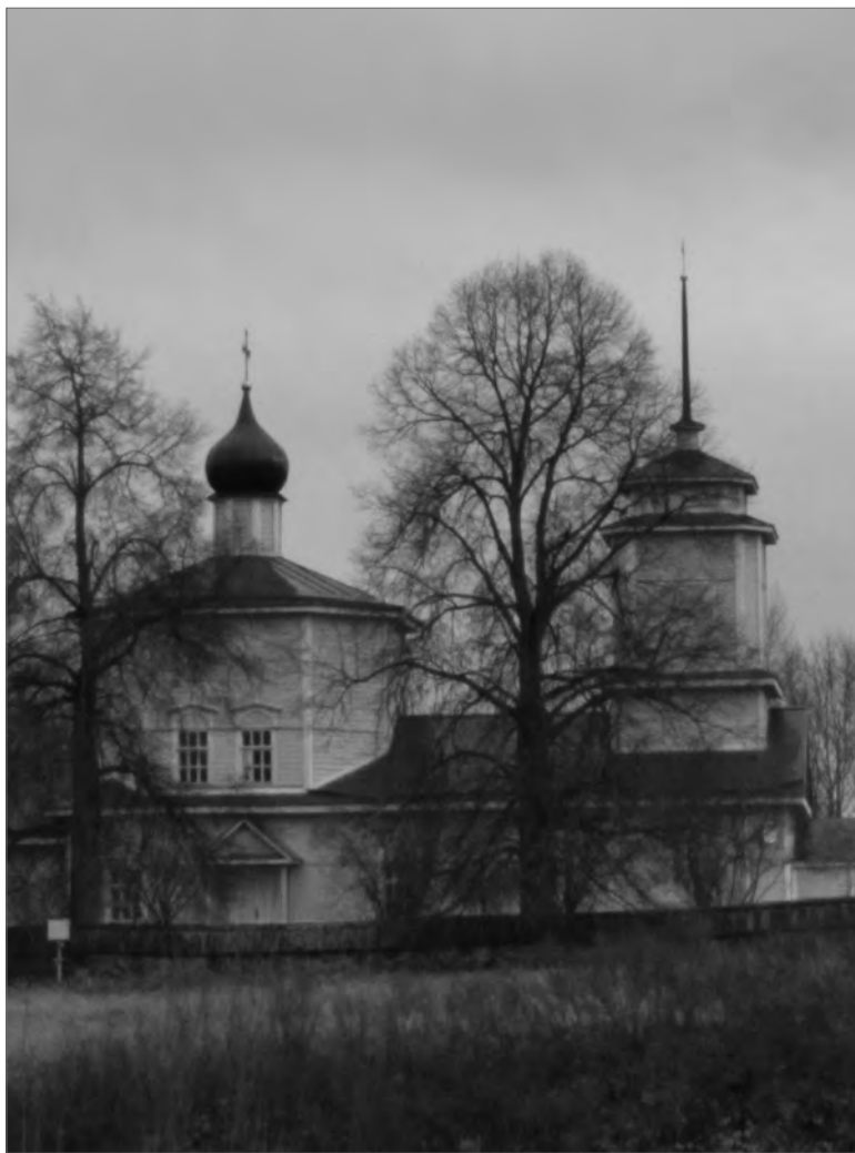
Рис. 11. Георгиевская церковь. 2021 г., фото Козминой М.А.
