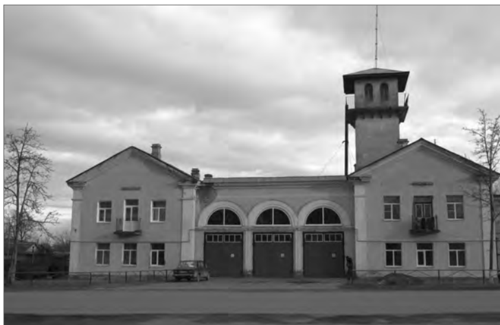
Рис. 6. Здание пожарной части в гор. Порхове: современный вид (фото с интернет-ресурса st.roll.ru )
