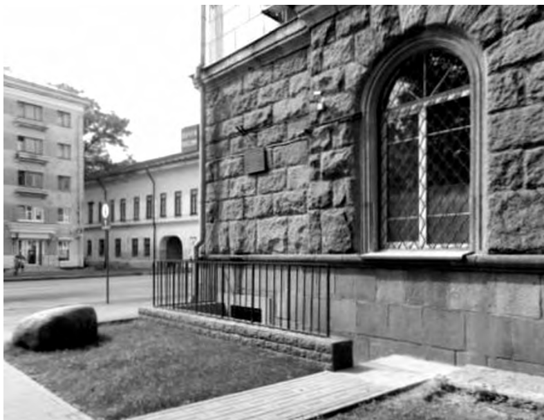
Рис. 2. Облицовка фасада Главпочтамта сделана изборскими каменотёсами
