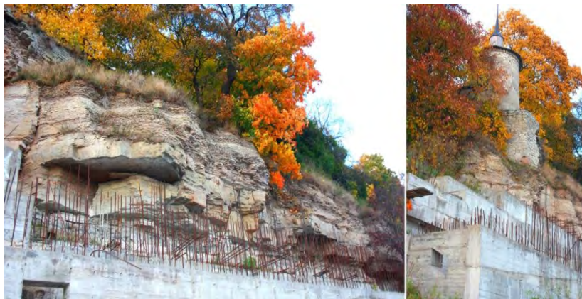
Рис. 4. Закрепление обнажения горных пород обрывистого берега на Снятной горе
