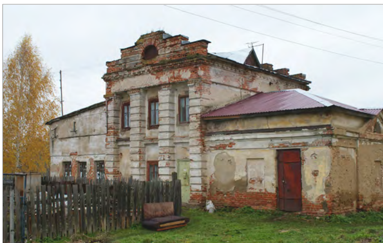
Хозяйственная постройка усадьбы. 2013 г.
