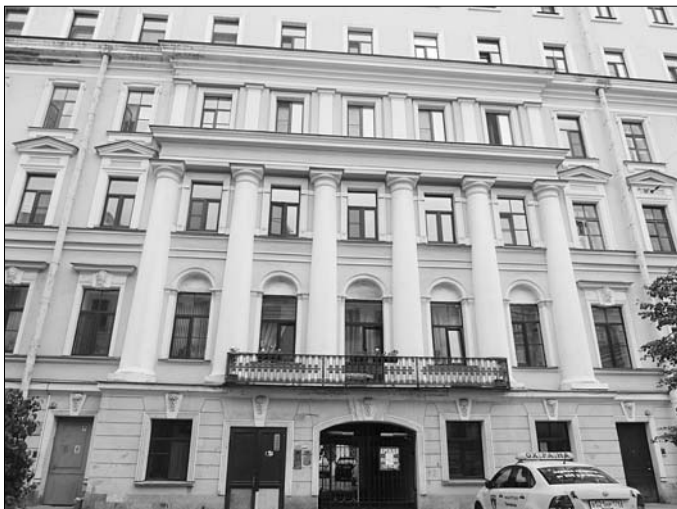
Пл. Чернышёва (ныне Ломоносова) Здание Министерства народного просвещения Здесь до 1909 года располагалось Русское Географическое общество, членом которого был И.А. Стебунт
