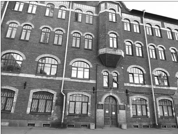
Бобруйская ул., д. 4. (б. Новая) Здание Стебутовских женских сельскохозяйственных курсов
