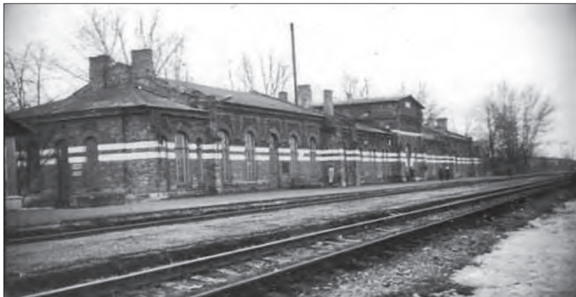
Здание железнодорожного вокзала станции Невель
